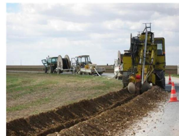
Figure 50 : Réalisation de tranchées du raccordement externe dans l'emprise des voies existantes (Source : EDF Renouvelables)
