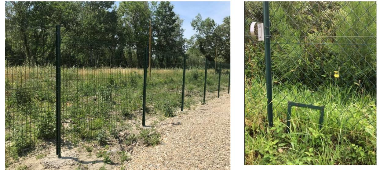
Figure 37 : Exemples de clôture (gauche) et passe-faune (droite) (Source : EDF Renouvelables)
