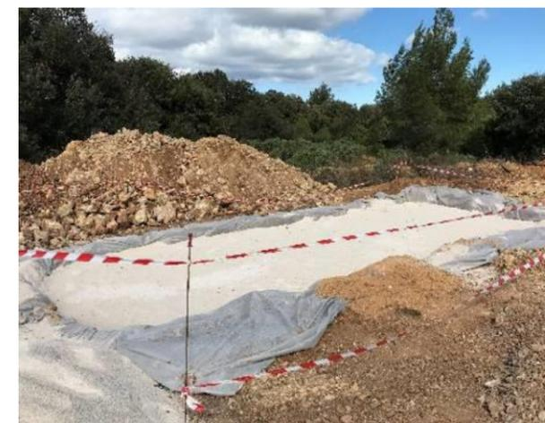
Figure 49 : Fouille préparée pour la pose d'un poste de conversion/transformation (Source : EDF Renouvelables)
