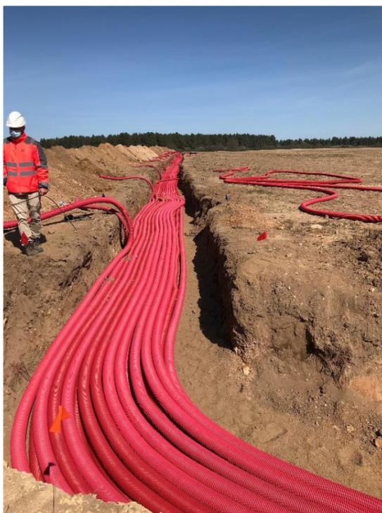
Figure 48 : Exemple de réalisation de tranchées du raccordement interne (Source : EDF Renouvelables)
