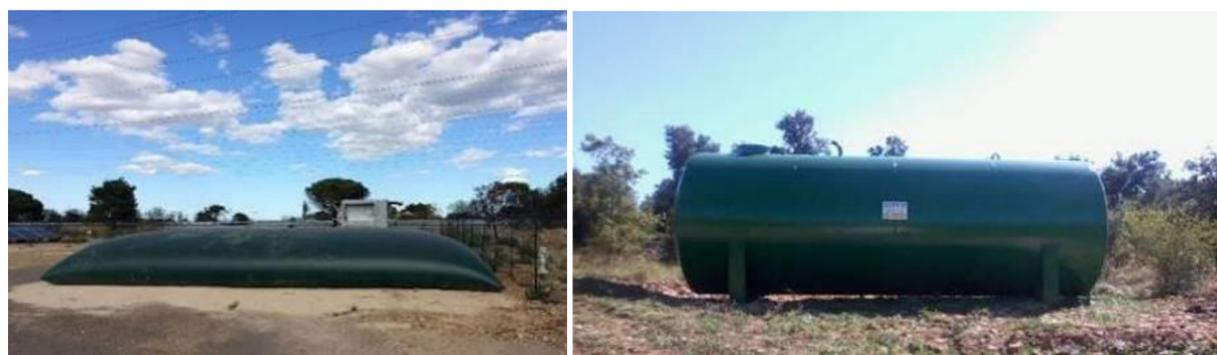
Figure 39 : Exemple d'une citerne souple et d'une citerne en dur (Source : EDF Renouvelables)
