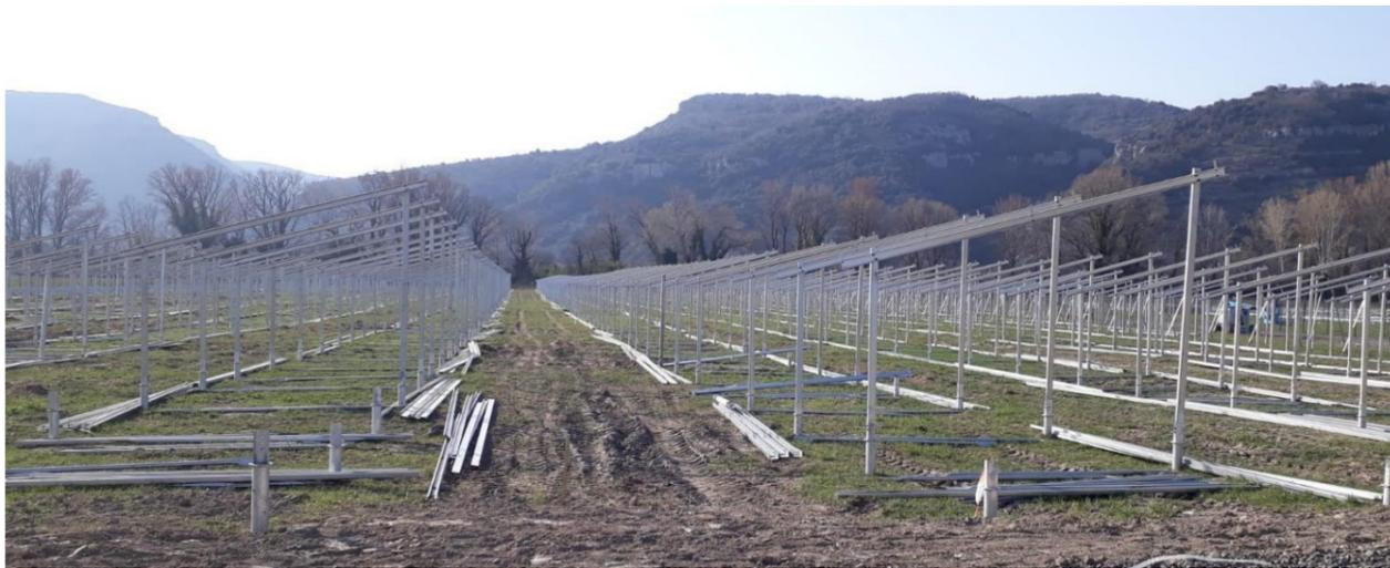
Figure 31 : Exemple de structures et fondations par pieux en acier
